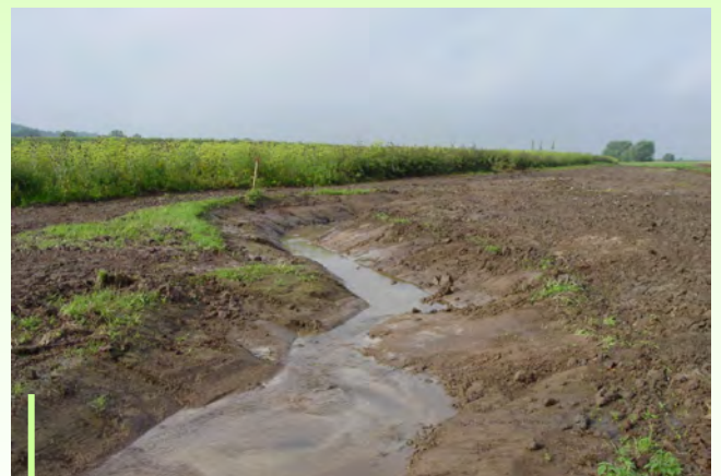
Offenlegung des Baches am Totenhof
