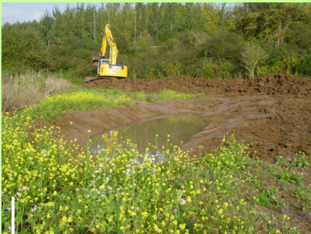
Anlage von Tümpeln neben dem Brandbach
